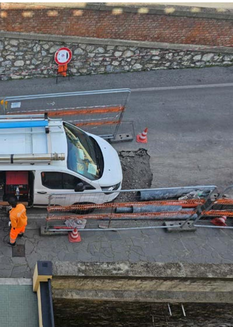
L'intervento consiste nella realizzazione di una palificata di micropali e tiranti per scaricare il muro che sostiene via Roma dalla spinta del terreno
